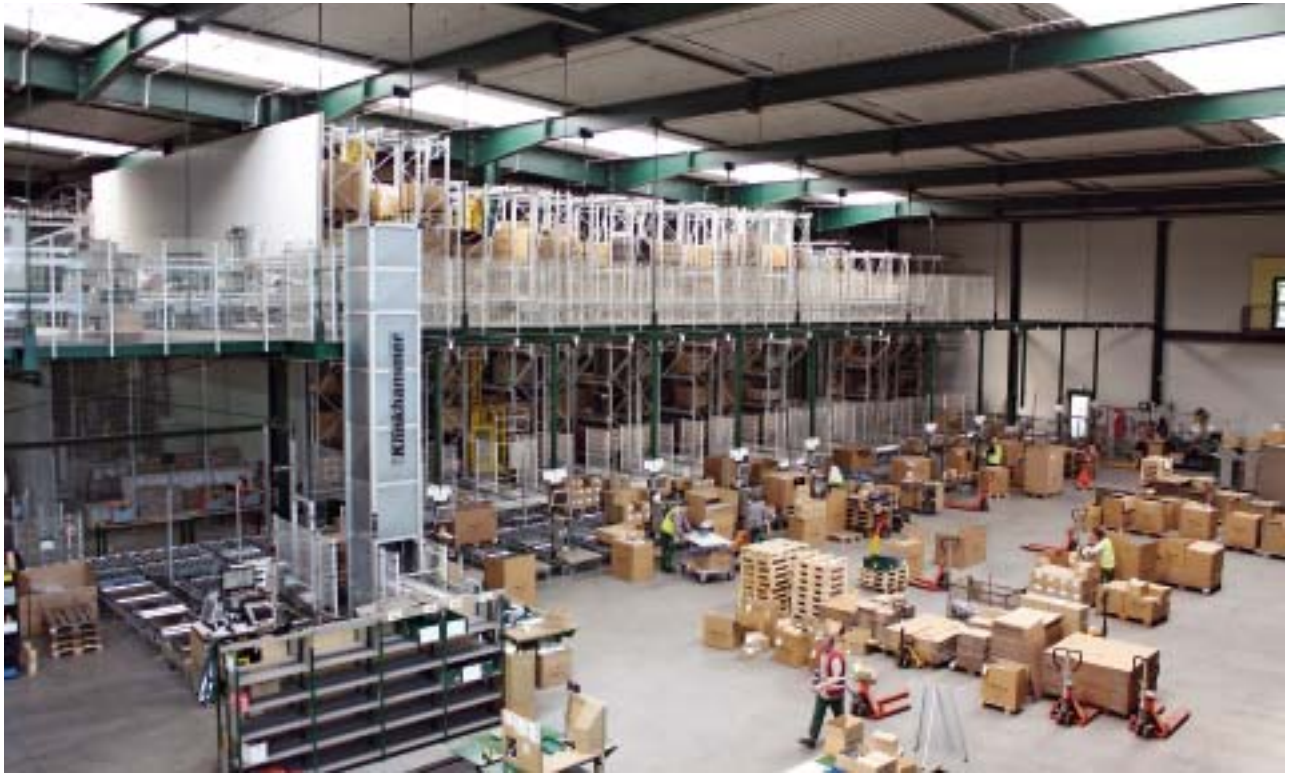
Blick in das neu gebaute Zentrallager mit siebengassigem Hochregal. (Fotos: Klinkhammer)
